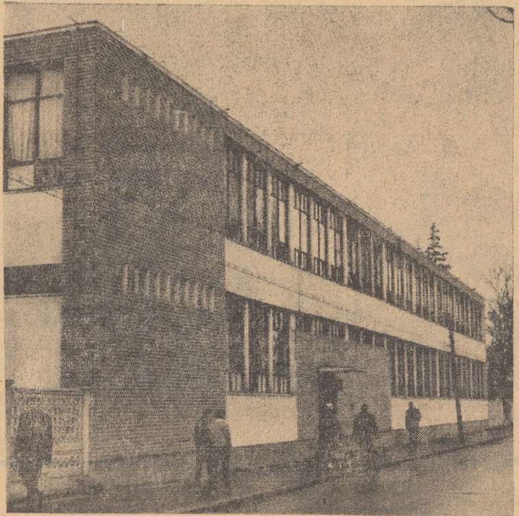
Noua construcție a sectorului creioane de la Iprofil „Republica” din Sibiu
