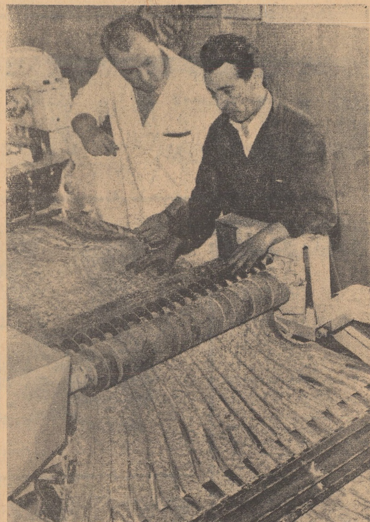
În secția patiserie a fabricii „Victoria” din Sibiu, a fost dată, de curind, în funcție o mașină de tăiat, distribuit și așezat aluat de turtă dulce, concepută de ing. Nicolae Munteanu și maistrul Mihai Ghenie
