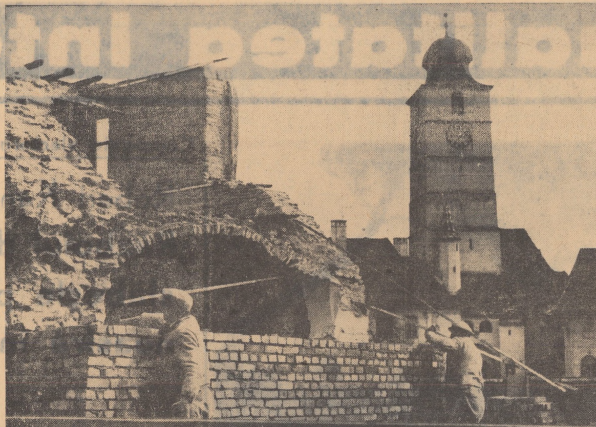
Cititorii ziarului nostru au aflat, dintr-un articol apărut anterior că vestita Casă a cojocarilor, din Piața 6 Martie, din Sibiu, cunoaște în aceste zile febra unei mari renovări. Lucrările începute (fotografia noastră) vor readuce acest monument istoric la aspectul lui din secolul al XVIII-lea. Foto: Fr. NUSS
