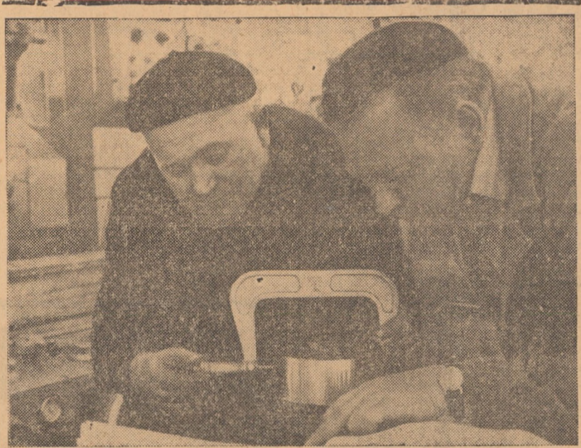
Comunistul Grigore Teureanu de la Uzina mecanică Sibiu, realizează repere a căror cote de prelucrare au toleranțe de ordinul micronilor. În stînga fotografiei înmănășcă cu maistrul secției, Ion Adam, verificînd cotele unei dintre piesele finite.
