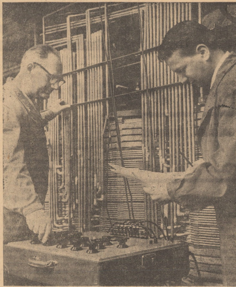
I.R.F. Sibiu. Vasile Dimbovean (dreapta), șeful secției C.T.C., împreună cu Wilhelm Kopschitsch, electrician specialist, la standul de probă, verificînd un transformator de 3,2 MVA
