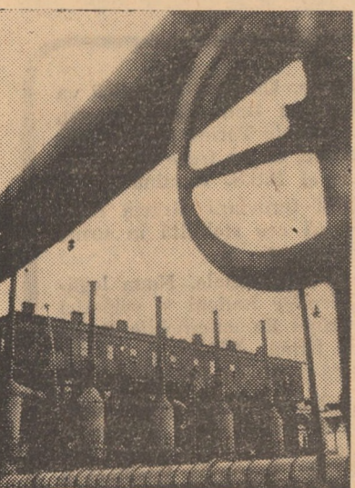
Instalația de negru de fum tip furnal
