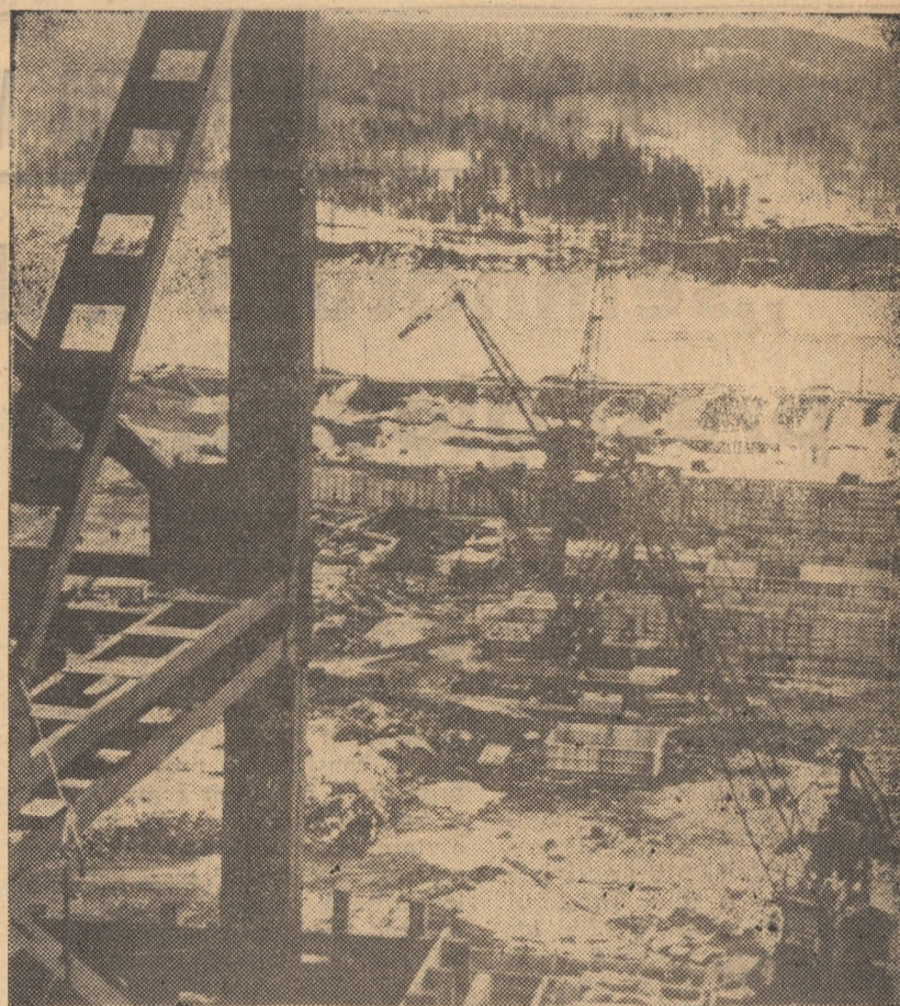
U.R.S.S. Aspect din timpul construcției hidrocentralei Ust-Ilmski
