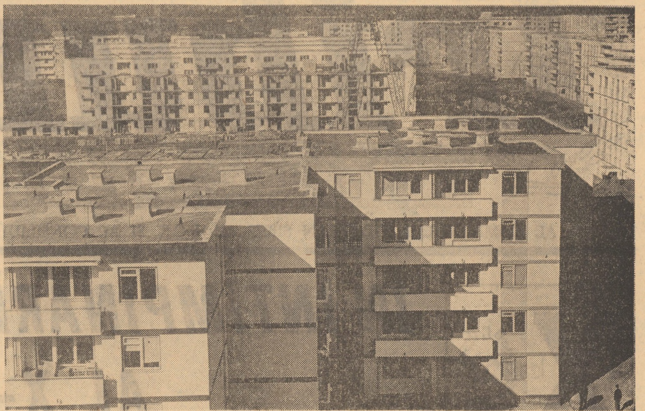
Din noul peisaj al construcțiilor de locuințe din municipiul Sibiu: cartierul Hipodrom
