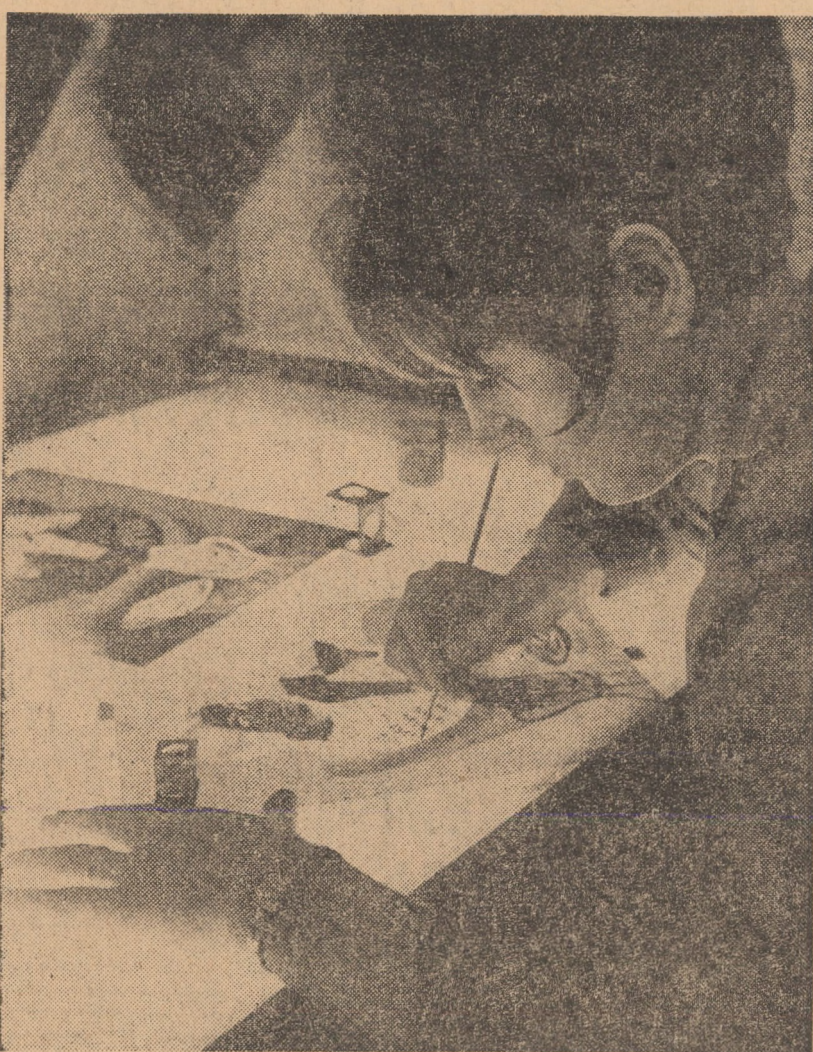
Retușul clișeeilor la secția ofset a Întreprinderii poligrafice Sibiu Foto H. BUCHFELNER
