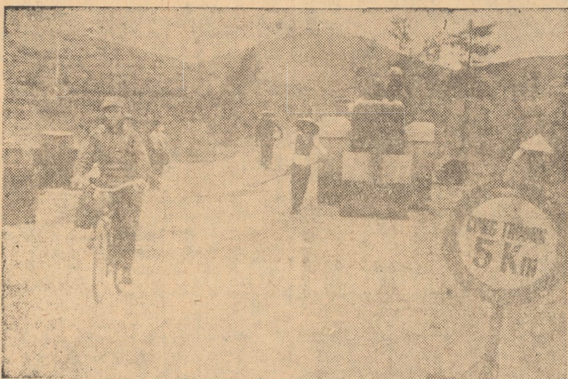
R.D. VIETNAM. Acțiunea de reparare a unei sosele, distrusă de bombardamentele aviației americane, în provincia Than Hoa
