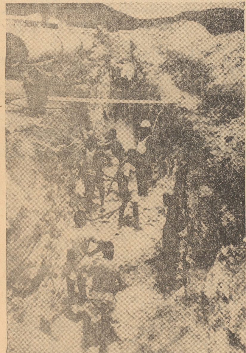
CAMERUN. În majoritatea țărilor africane, apa este una din problemele vitale. În Camerun, fără situație pe țărmul Oceanului Atlantic, apa este condusă prin conducte, în Camerunul central și distribuită la sate. În fotografie: Aspect de la lucrările de plasare a conductelor
