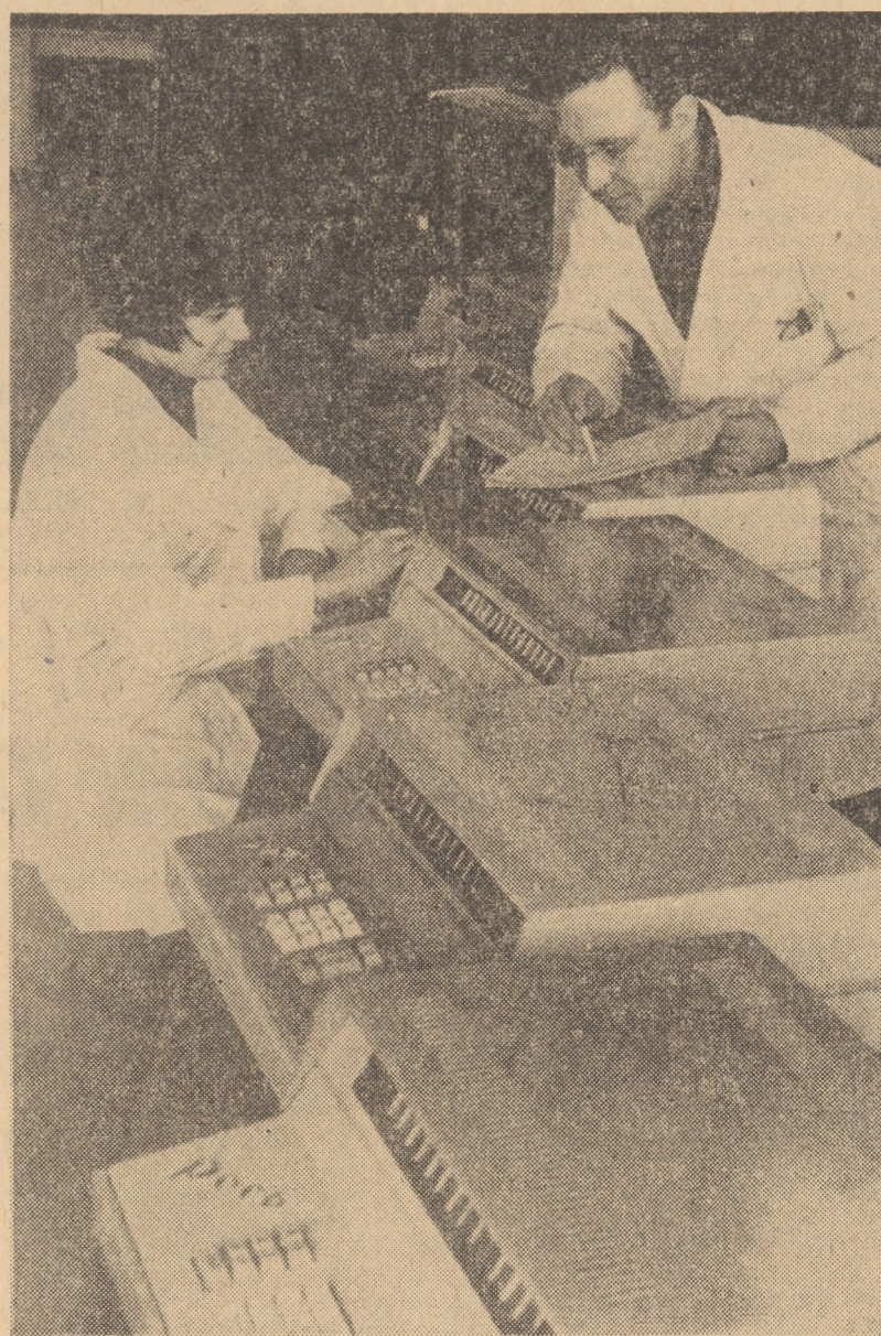
U.R.S.S. La uzina „Tociectre- pribor” a început producția primelor mașini electronice de calcul „Ros”, care efectuează patru operații aritmetice, extrage rădăcina pătrată și ridică la putere. În foto: în secția de ver- ficare a mașinilor electronice
