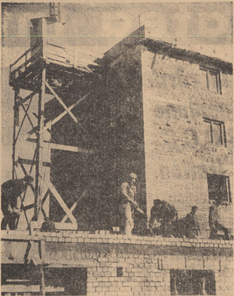
Noile construcții din cartierul de locuințe din orașul Agnita se află într-o fază avansată. În cursul următoarelor zile va fi predat blocul nr. 5 iar cheile blocului nr. 7 urmează să fie înmăinate locatarilor la mijlocul lunii mai a.c. În fotografie: aspect de pe șantier
