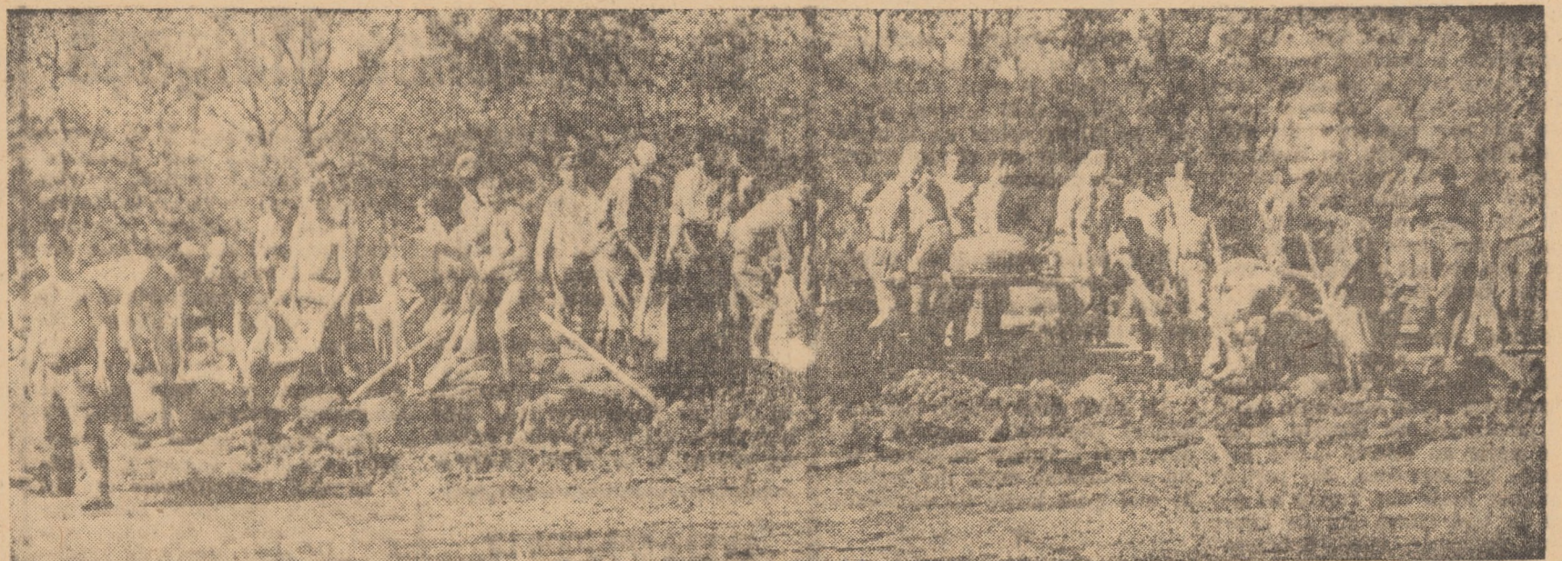
Peste 100 de militari lucrează la un dig care va stăvi apele Tirnavel la ferma horticolă din Brateiu a I.A.S. Mediaș. Acest dig va feri de eventuale inundații un cartier din apropiere al Mediașului, în care locuiesc circa 5.000 de oameni, precum și două obiective industriale: uzina „Automecanica”, uzina „Tirnavă” și sediul Școlii tehnice de aviație
