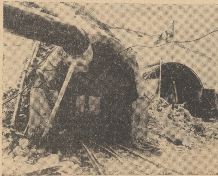
ELVEȚIA. Tunelul Saint Gotthard cu completările care i se vor face în 7-8 ani, va avea o lungime de 16,3 km și va fi cel mai lung tunel rutier din lume. În foto: Începerea lucrărilor la partea de nord a tunelului, care actualmente are 350 m lungime
