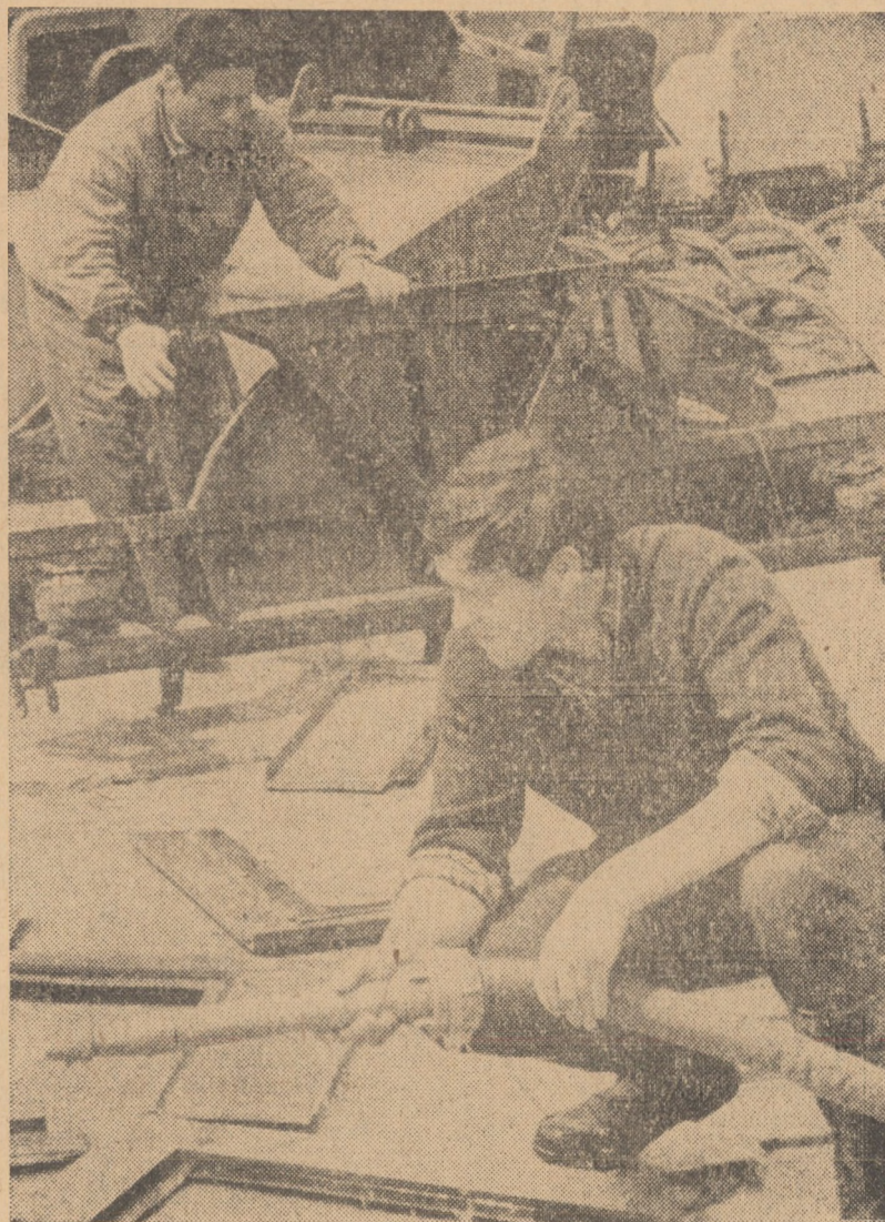
Rind pe rind, printr-o muncă asiduă, subansamblele ce alcătuiesc „Automecanica” din Mediaș, cuprinse de inundație, se spală de nămol, se curăț și se usucă pentru a fi redată apoi procesului de producție
