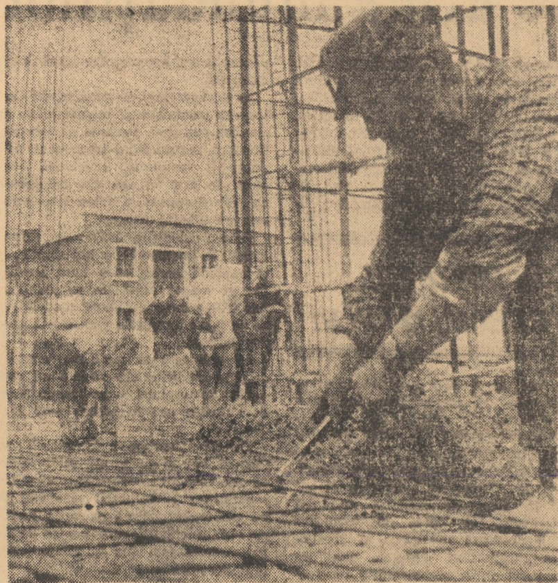
Pe șantierul de construcție al uzinei „Independența” (sediul vechi) se ridică o hală care va găzdui sectorul gloană pneumatică. Noul edificiu industrial va fi construit pe o suprafață de cca. 6.900 mp
