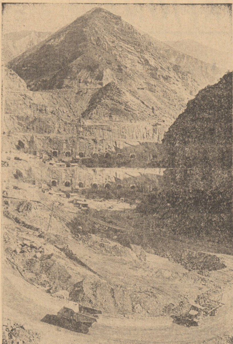
U.R.S.S. O vedere a lucrărilor de construcție a barajului hidrocentral Nurek. Pînă acum s-au turnat 18,2 mii de metri cubi de beton.
