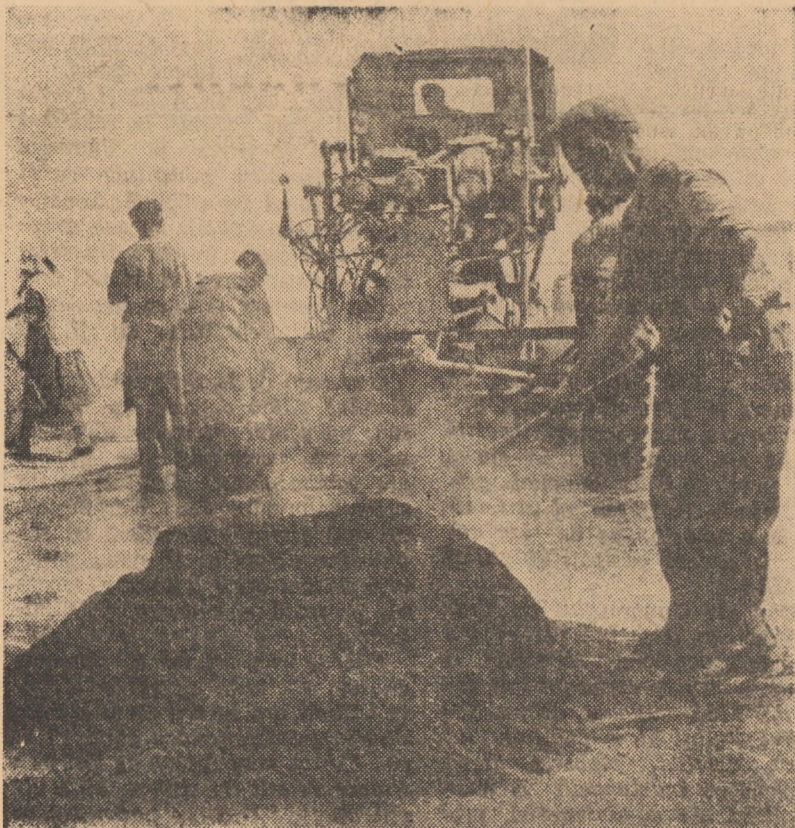
Lucrări de întreținere a părții carosabile pe drumul național nr. 1
