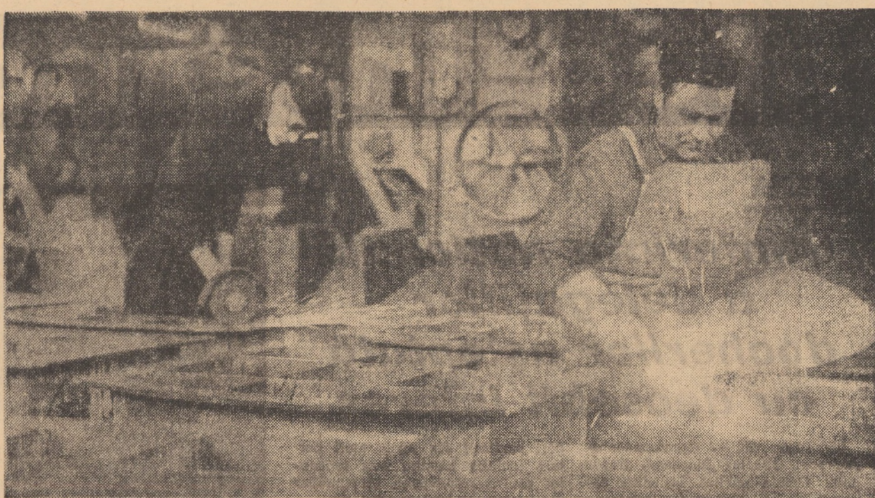
Lucrări de asamblare la cuptoare electrice pentru tratamente termice, produse de uzina „Independența” din Sibiu
