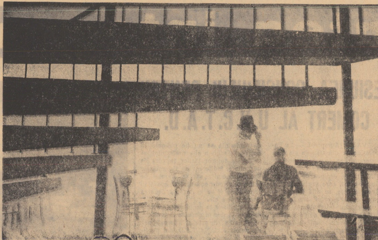
Din arhitectura modernă a noii cantine din stațiunea balneară Baza
