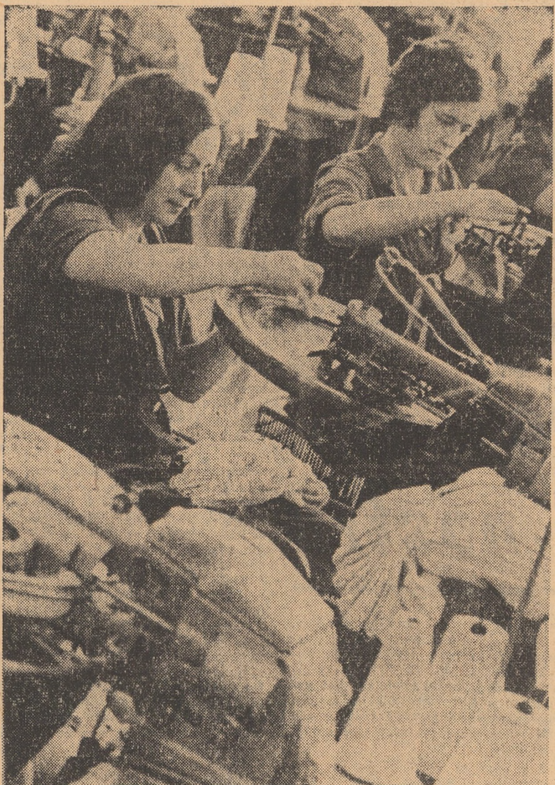
Imagine de la fabrica „7 Noiembrie” Sibiu. Ciorapii, o dată tricotați la mașinile circulare, urmează a fi cusuți la vîrfuri cu ajutorul unor mașini de încheiat (fotografia noastră)
