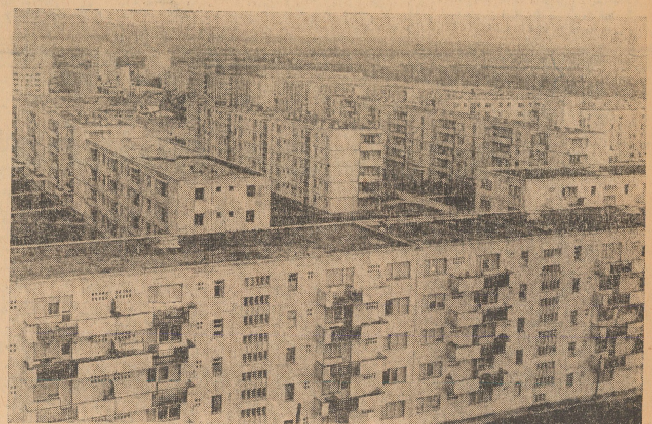
Din peisajul noilor construcții de blocuri în municipiul Sibiu: cartierul Hipodrom
