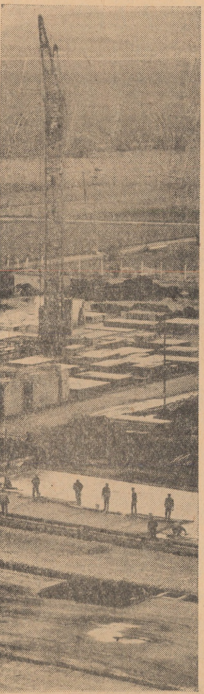
Cartierul Hipodrom. Stația de turnare a prefabricatelor folo- site în construcția blocurilor de locuințe
