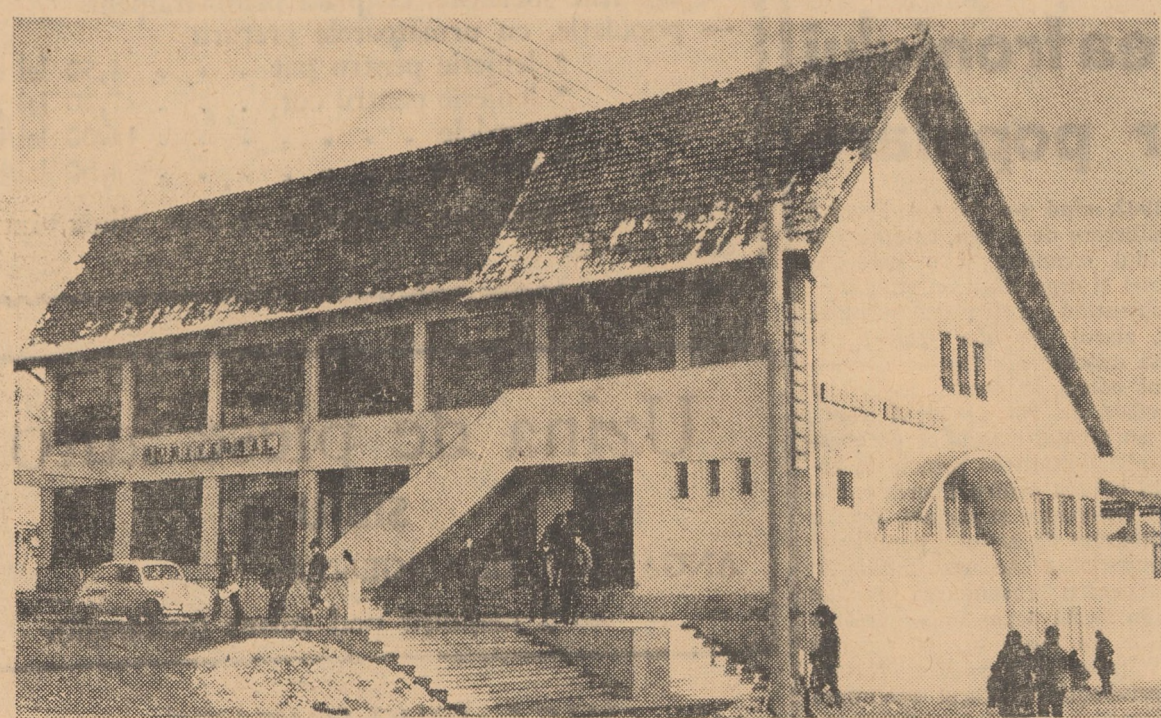
Noul complex comercial din Avrig
