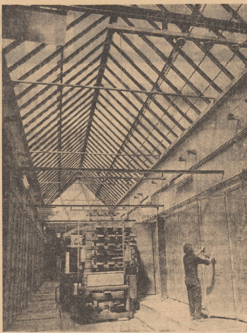
Folosind vagonete speciale de încălzire și descărcare, din uscătoare fabricate de produse ceramice „Record” Sibiu se obțin zilnic ca 120.000 buc. cărămizi uscate, gata de livrat
