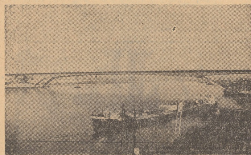
R.S.F. IUGOSLAVIA. Dăm citeva imagini ale noului pod peste Sava, podul „Gazelle”, numit așa din cauza liniei grațioase care parcă imită saltul unei gazele. Podul, lung de 473,5 m construit din 6.000 tone de oțel, este prin soluțiile tehnice adoptate, unul din podurile de avangardă ale lumii. El face legătura cu șoseaua Zagreb—Belgrad, cu estul și sudul
