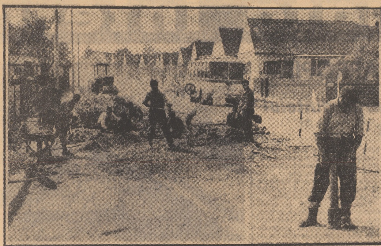
Lucrări de lărgire a șoselei Alba Iulia (DN 1) la 4 benzi de circulație între aeroport și str. Lenin, Sibiu
