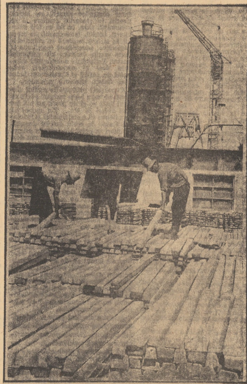
Depozitul de prefabricate din Orlat a întreprinderii industriale județene NACO Sibiu
