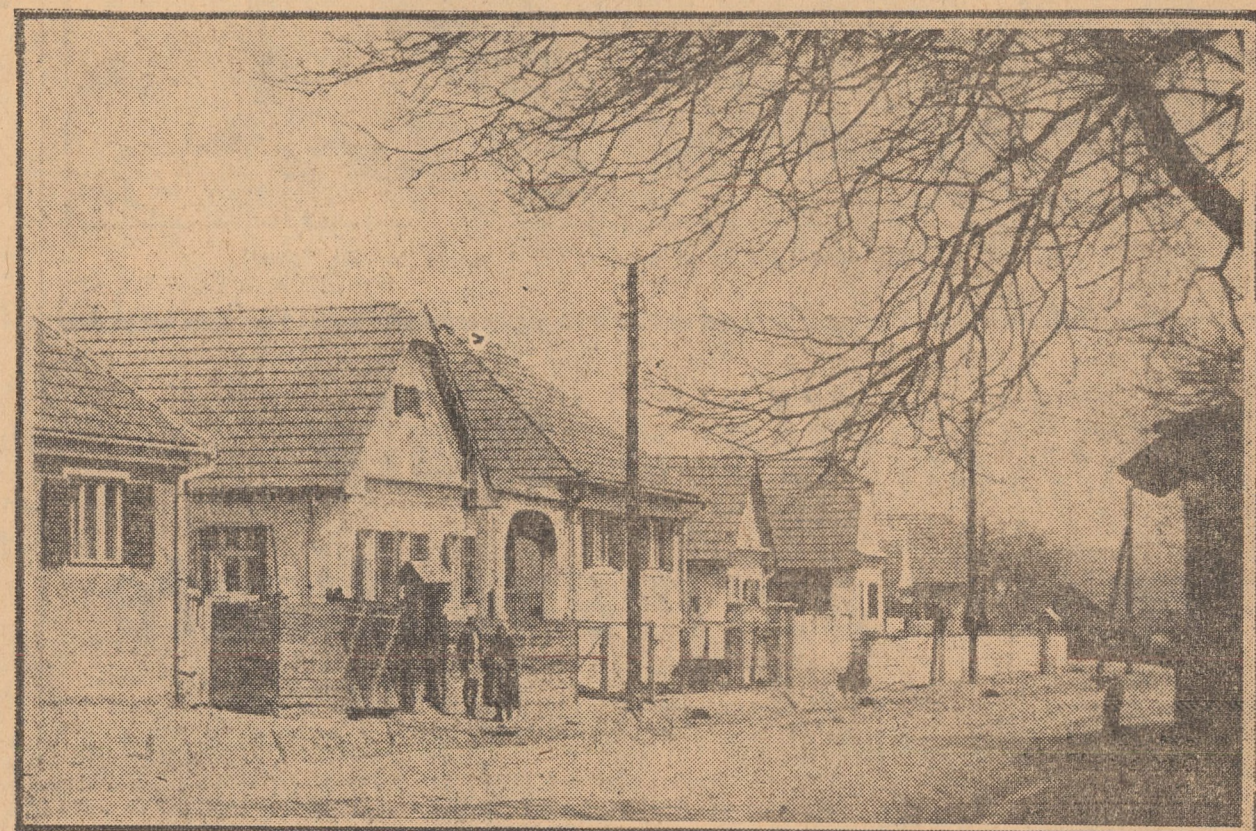
Construcțiile de locuințe s-au dezvoltat intens și în satele comunei Păuca în anii socialismului. Casele noi au schimbat fizionomia localităților. În foto: stradă pînceană
