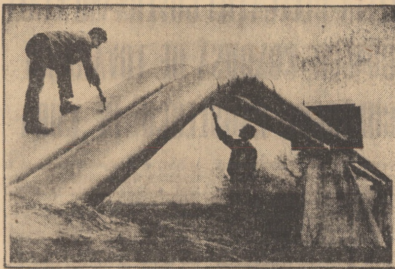
Aplicarea unui strat anticoroziv pe o porțiune de conductă la traversarea peste rîu, una dintre multiplele operații de întreținere a magistrelor de gaz metan
