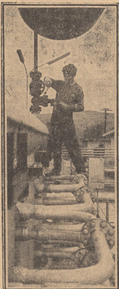
Lucrări de întreținere a instalațiilor întreprinderii de gaz metan Mediaș
