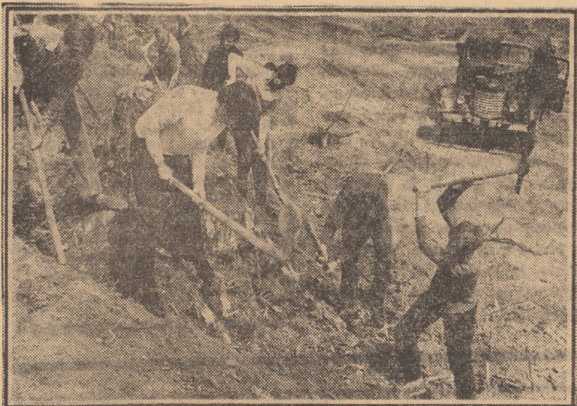
Lucrări de amenajare a terenului la viitorul patinoar artificial din Sibiu, efectuate de uteciști
