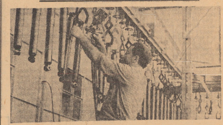
Veședă parțială a instalației de U.P.A.S.I. și fosfatare automatizate...
