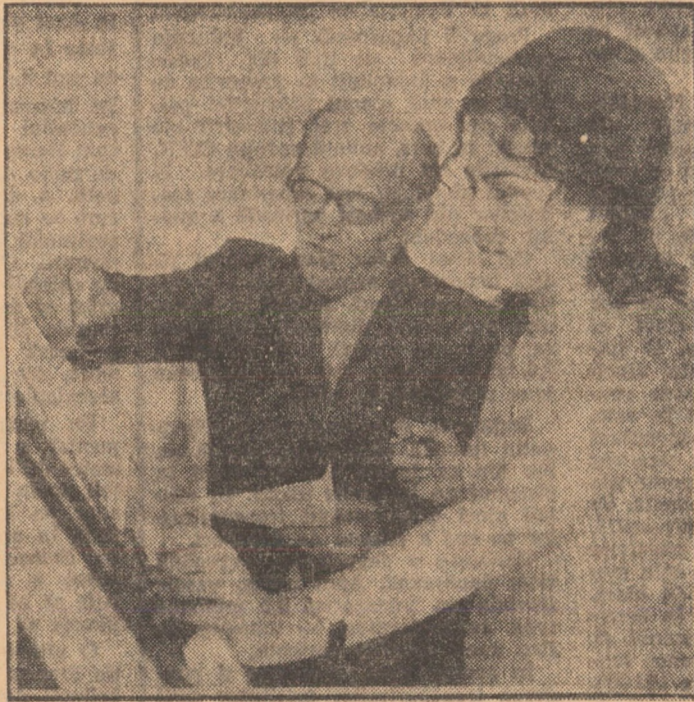
În atelierul de proiectare al Centralei Industriale de gaz metan Medias, Margareta Szentgyörgyi și Gheorghe Sucu lucrează la proiecte pentru instalații tehnologice la sonde cu gaz
