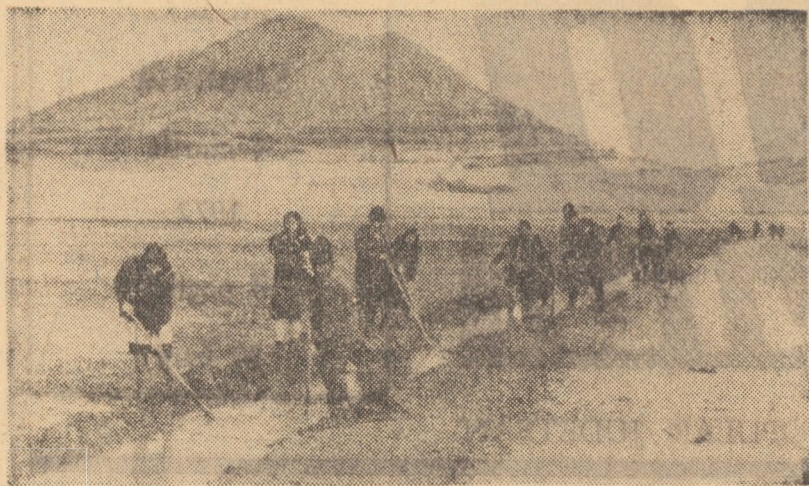
Cetățenii satului Boia, din cadrul comunei Tălmăciu, participă la executarea canalului de desecare de pe terenurile agricole
