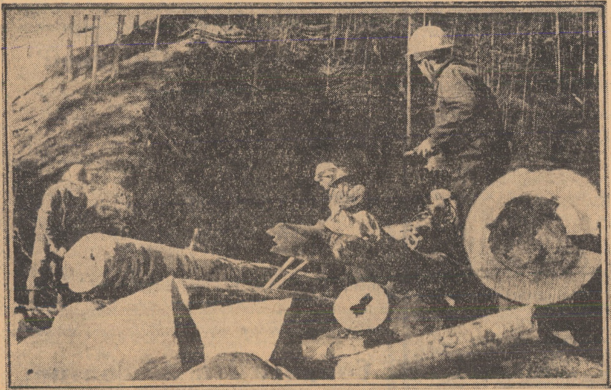
Activitate susținută la secționatul buștenilor în parchetul „Prislop”, sectorul de exploatare Riul Vadului.
