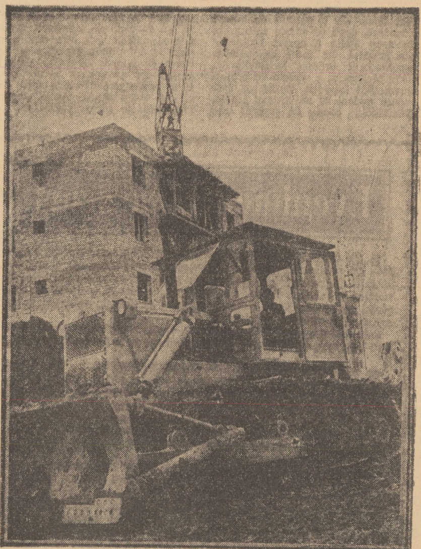
Lucrări de nivelare a aielor carosabile în preajma nollor blocuri ce se construiesc în cartierul Gura Cîmpului din municipiul Medias.
