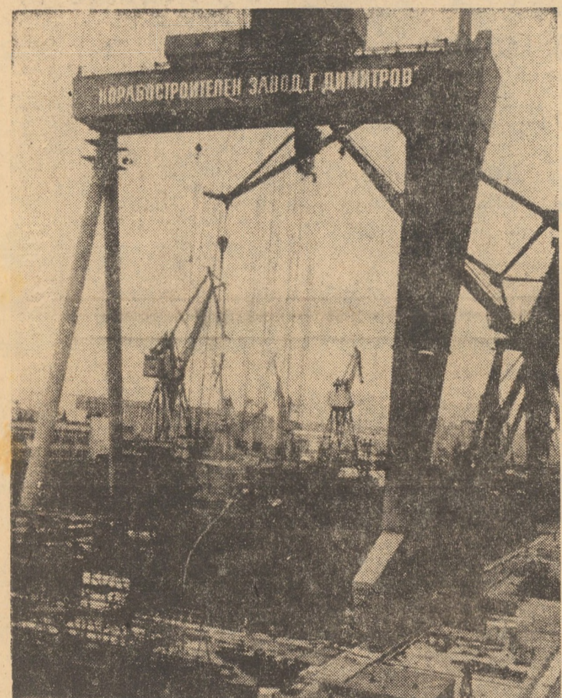
R. P. BULGARIA — Construcția de vapoare poate fi considerată una dintre ramurile cele mai dezvoltate ale economiei R. P. Bulgaria. Datorită caracteristicilor lor superioare, vapoarele construite în șantierul naval bulgar sunt solicitate pe piața externă, inclusiv în țările cu tradiție în această industrie.
