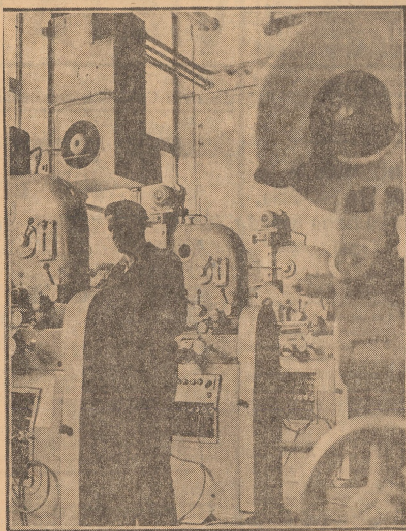
În anul 1973 în cadrul G.U.P.U.S. se vor executa pentru export 120 de mașini automate de ascuțit discuri de fierăstrău în diametru de 200-1200, pinze gater și panglică. În fotografie: Un lot de asemenea mașini în ultima fază de montare
