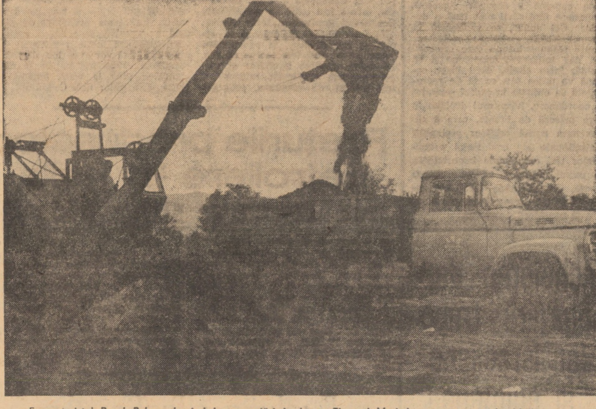
Excavatorul Pavel Polgar, lucrînd la amenajări în lunca Tîrnavei Mari, în zona municipiului Medias. Foto: Ing. MIREA COLCERIU
