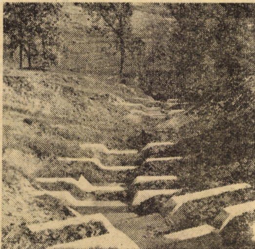
Amenajări anticorozionale la Capilna Dumbrăveni Foto: ing. Mircea COLCERIU
