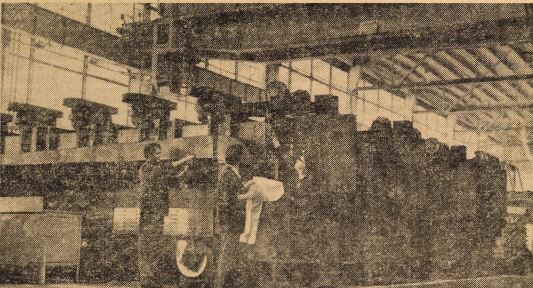
Un utilaj uriaș executat la Independența II Sibiu, destinat Fabricii de șuruburi Tg. Secuiesc: cuptor de tratament termic executat de echipa condusă de Vasile Luca
