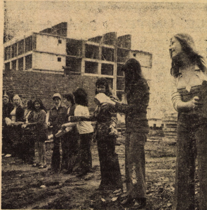
Pe șantierul de locuințe din cartierul Vasile Aaron Sibiu
