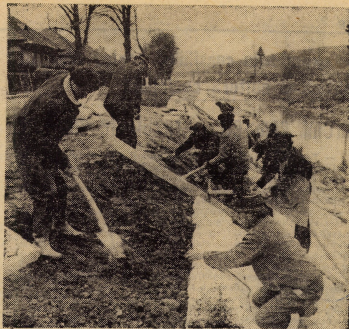
Agnita: se lucrează intens la taluzarea cu dale din beton a malurilor riului Hirtibaciu
