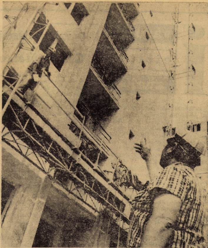
Pînă la sfîrșitul acestei luni, în cartierul de locuințe „Vasile Aaron” din Sibiu, vor fi predate beneficiarilor un număr de 700 apartamente. În imagine: blocul nr. 57, la care echipa condusă de Albert Keteșdi execută ultima porțiune de finisaj exterior
