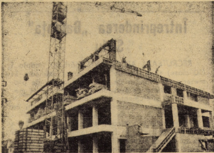
Complexul din Agnita, aflat în construcție, va dispune de o suprafață comercială de cca. 2 400 m.p. dispuse pe 4 nivele. Termenul de predare: trimestrul I al anului viitor
