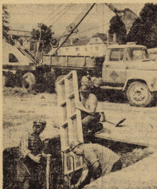
De curînd, pe terenul vechiului cîmîntir (B-dul 23 August) au început lucrările pentru ridicarea noului spital-policlinică. După decuparea terenului în spații largi, au fost deja efectuate săpături și turnări de betoane (peste 200 m.p.) la fundații izolate la corpul I.
