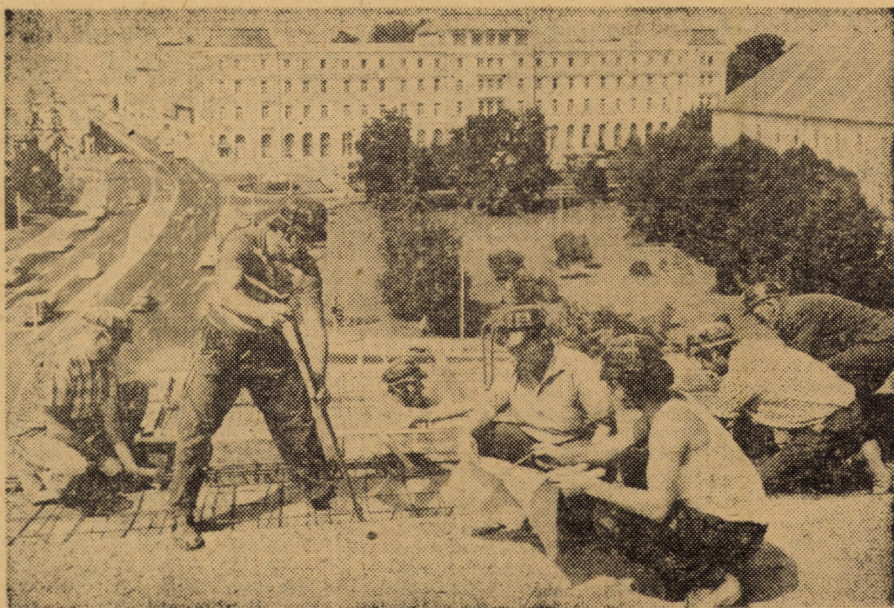
Secvență de lucru surprinsă pe șantierul nr. 3 lotul II Sibiu: magazinul universal (str. Gheorghe Gheorghiu-Dej). Echipa de dulgheri, condusă de Ion Schenn lucrează la montarea cofrajelor și a prefabricatelor la ultimul nivel (terasă). Cum reiese din angajamentul echipei, pînă la sfîrșitul acestui an vor fi terminate toate lucrările de dulgherie
