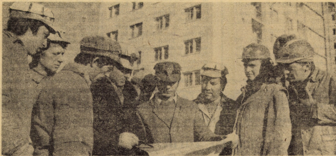
Un grup de muncitori finisori, conduși de maestrul Dumitru Răchită, de la Șantierul nr. 2. Lotul 4, — cartierul „Vasile Aaron”, discutînd despre noile operațiuni ce vor conduce la terminarea blocurilor 5, 8 și 10 cu un avans de 15 zile față de plan Foto: FRED NUSS
