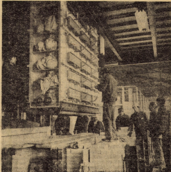
Secvență de lucru surprinsă în timpul montării barei de tras geam de la mașina cuptorului nr. 1 — Fabrica de geamuri Mediaș
